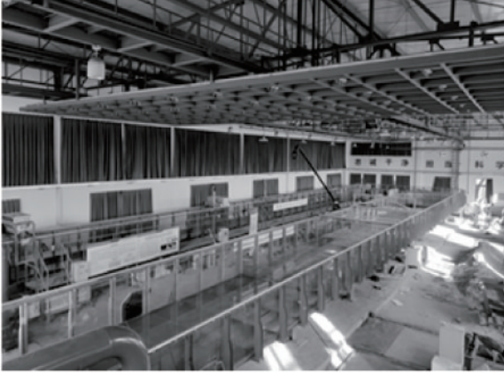
(a) 水槽现场图片
